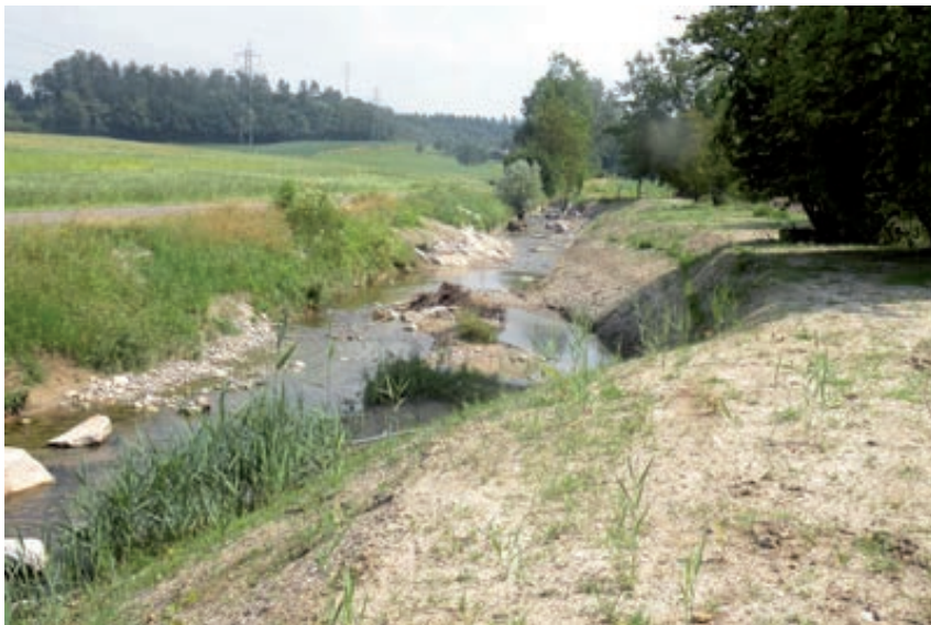
Die revitalisierte Bünz im Riverwatch-Abschnitt unmittelbar nach den Baumassnahmen. © WWF Schweiz
